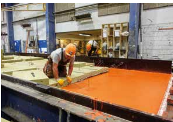
På besøg på fabrikken CRH Concrete i Esbjerg, hvor der blev lavet indfarvningsforsøg. På facadeelementet under opbygning ses bagsiden af facaden, hvor på isolering opbygges, inden den bærende bagvæg støbes. Foto: Flemming Sørensen
