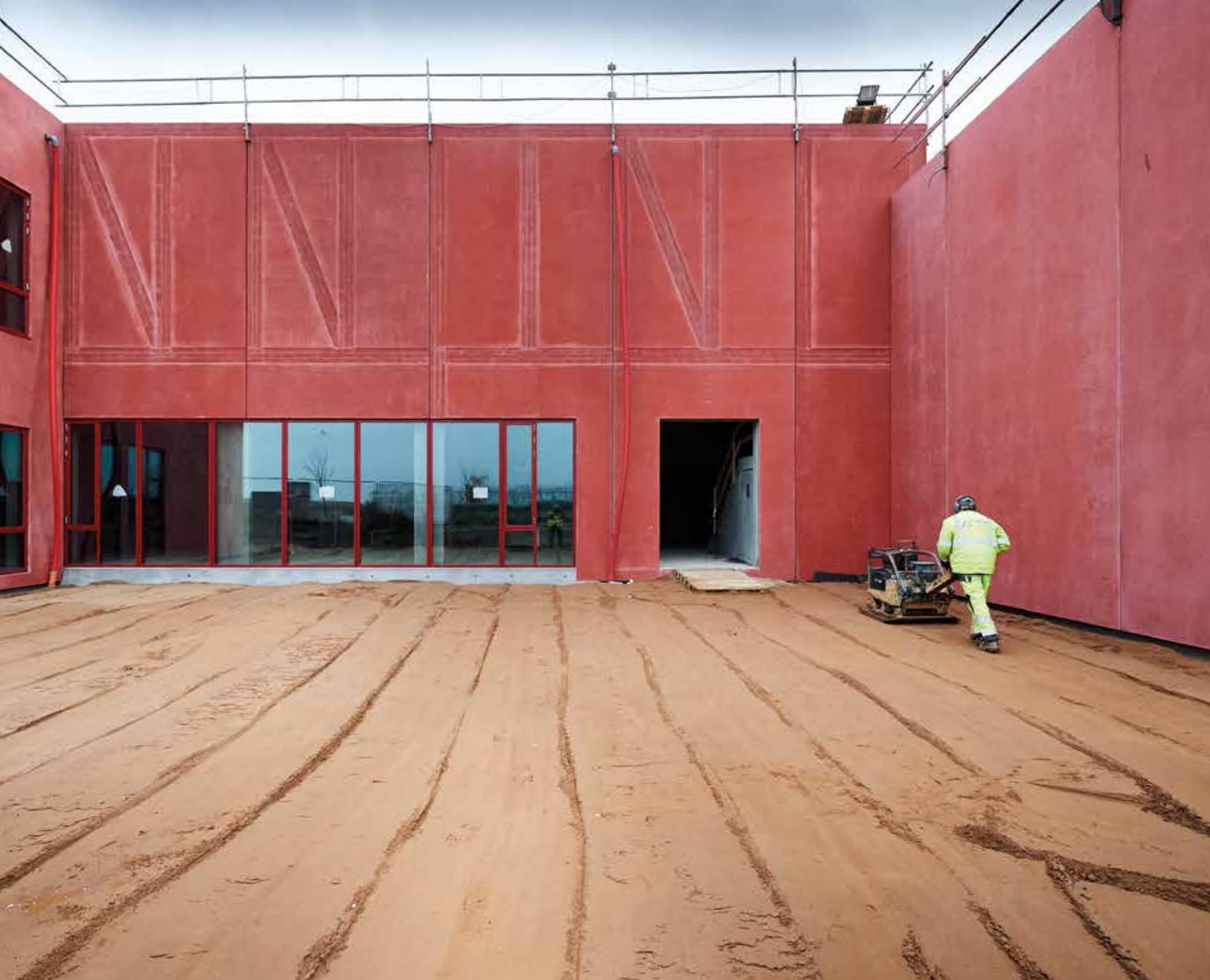
Indgangspartiet klar til flisebelægning.
