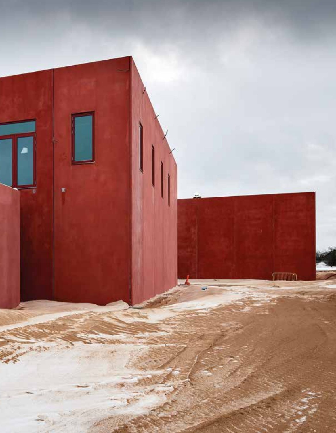
Vinduer og døre lukkede effektivt for kulden, da sneen vinteren 2021 faldt over byggepladsen.
