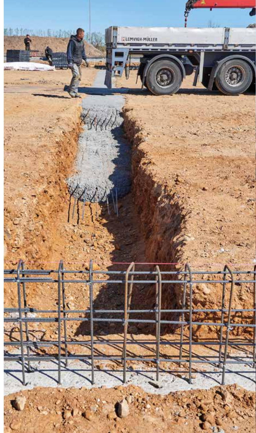
Støbning af fundament-renden til de bærende skillevægge i magasinet. Mens de fleste indervægge er 200 mm, er ydervæggene mere end det dobbelte – 475 mm.
