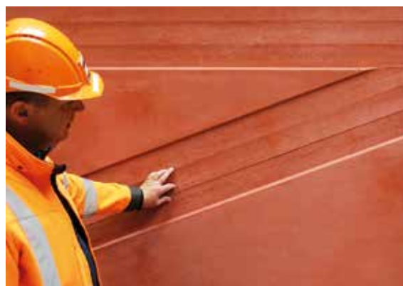
Detalje af "bindingsværket", betonfarve og tekstur vurderes forud for produktion af de mange betonelementer, der skal bruges på bygningens facade. Hvert element måler ca. 3,5 x 9,5 meter. Foto: Flemming Sørensen
