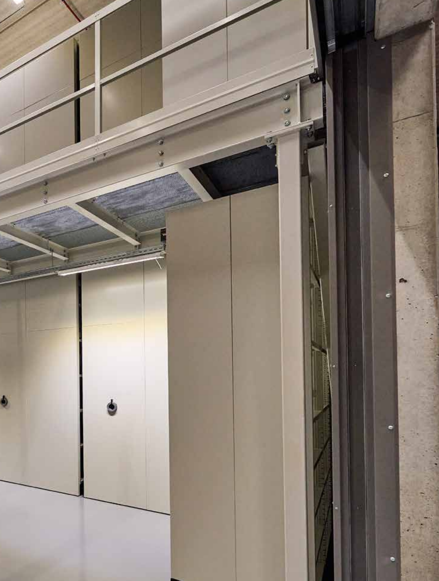
Tekstilrummet efter montering af reolsystemer. De øverste hylder og skuffer nås via mezzaninen til højre. Mezzaninen til venstre giver derimod adgang til malerimagasinet.
