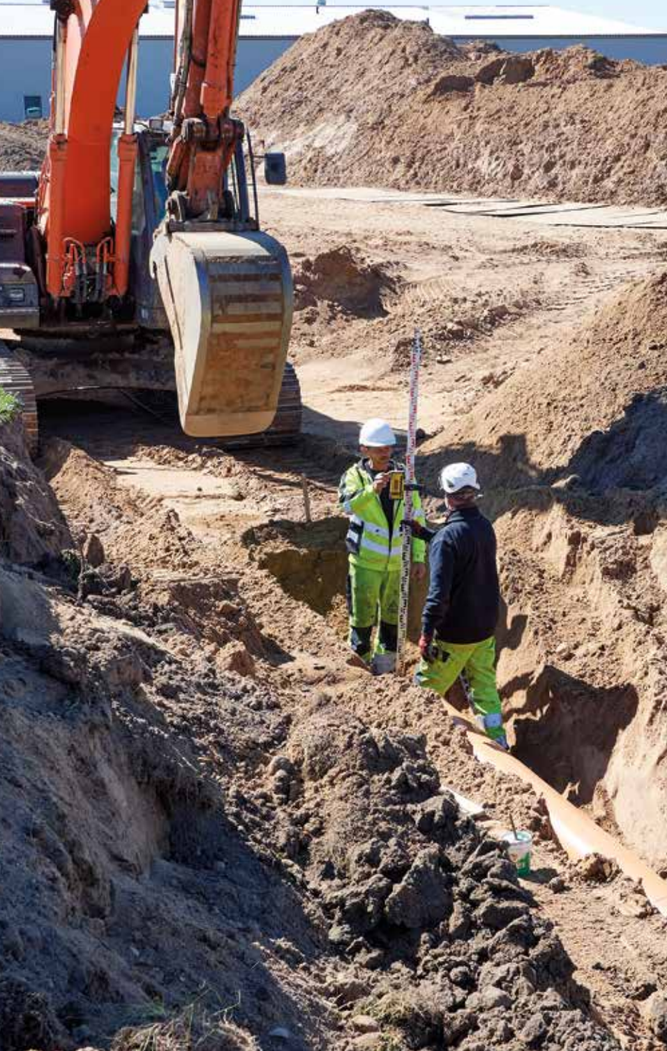
Hovedledningen til regnvandskloak, der løber tværs under bygningen, er det første der støbes ned i jorden.
